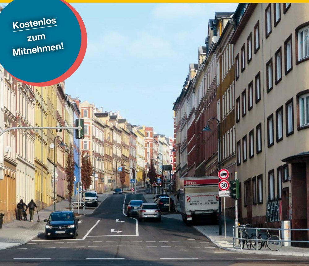
Rechtzeitig zum Kulturhauptstadtjahr – nach 760 Tagen – ist die Zietenstraße wieder frei und durchgängig über den Sonnenberg nutzbar. Mit zwei neuen barrierefreien Zebrastreifen und für die Nutzer der Ringbuslinie 82 mit einer auf beiden Seiten zusätzlichen Haltestelle in Höhe der Jakobstraße ist sie ausgesprochen fußgängerfreundlich gestaltet. Foto: Eckart Roßberg
