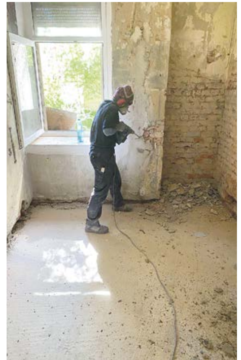
Genossenschaftsmitglied entfernt Putz mit Bohrhämmer. Foto: Gina Zimmerman
