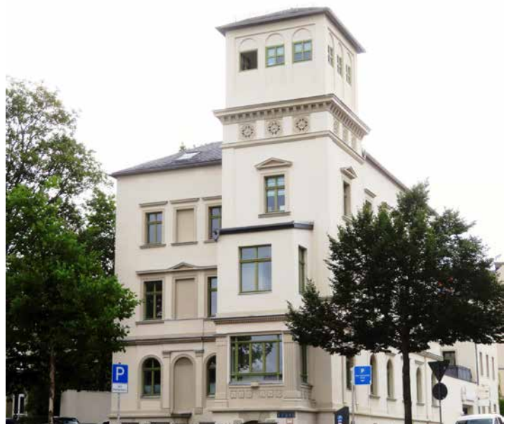
Villa Rudolph nach der Sanierung - 03.08.2024
