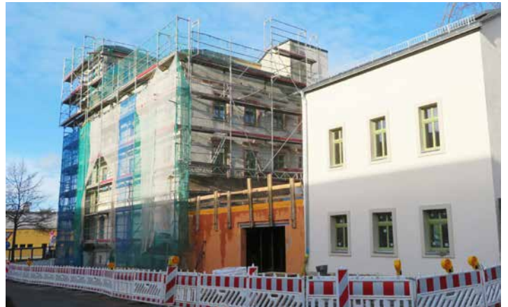
Sanierung – zwischen Villa und Hintergebäude Baugrube für das Restaurant - 15.06.2021
