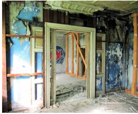
Abbruch der Wandverkleidung - 09.10.2010
