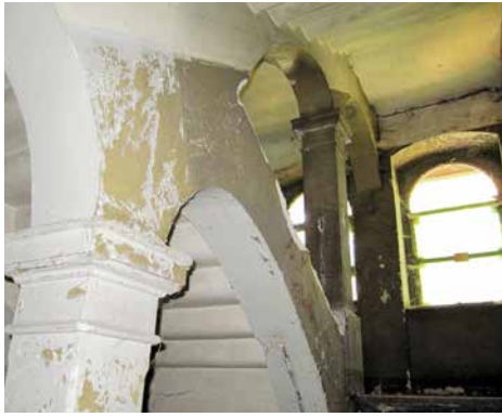
Treppenhaus der Villa - 09.10.2010.
