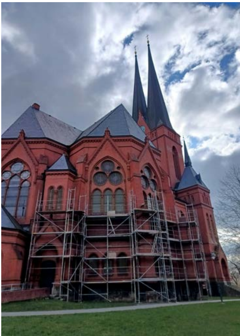
Sanierungsarbeit an der Markuskirche am Körnerplatz – Foto: Tobias Merz
