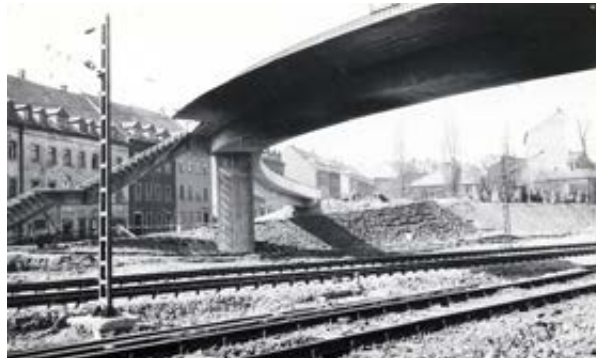
Neubau der Hainstraßenbrücke von 1965 – Sammlung Eckart Roßberg
