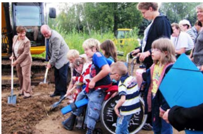
Schulleiterin Annett Goerlitz und eine Schülerin gemeinsam beim Spatenstich – Foto: Eckart Roßberg
